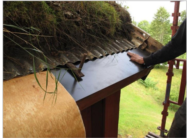
I stället för att lägga papp togs beslut om att lägga plåt långt ner i takfoten, lika mangårdsbyggnaden.
