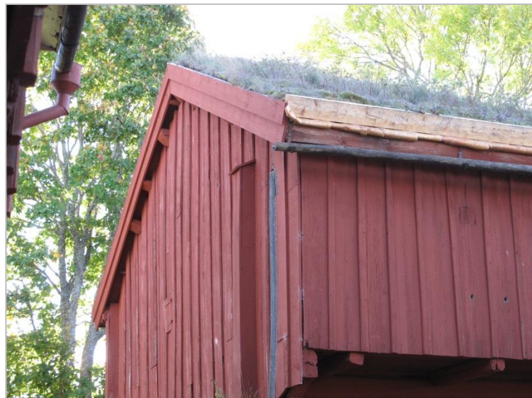
Takfoten och vindskivorna efter åtgärder.
