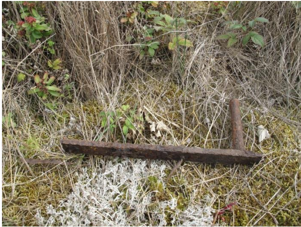
En av de befintliga krokarna som mullåsen ligger på.
