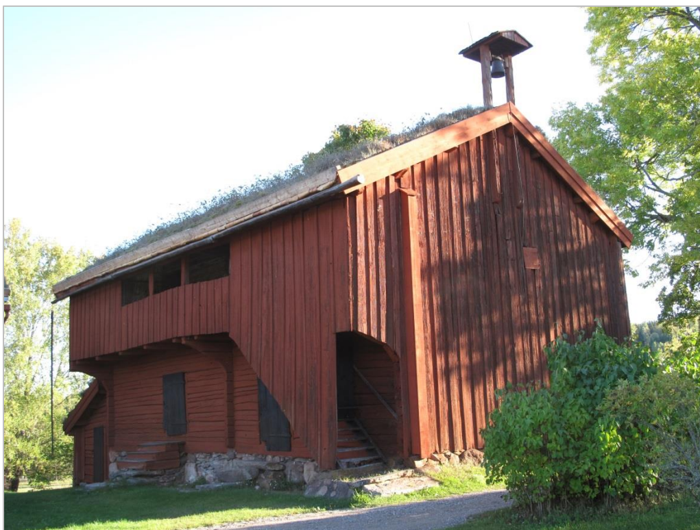
Loftboden efter åtgärder.
