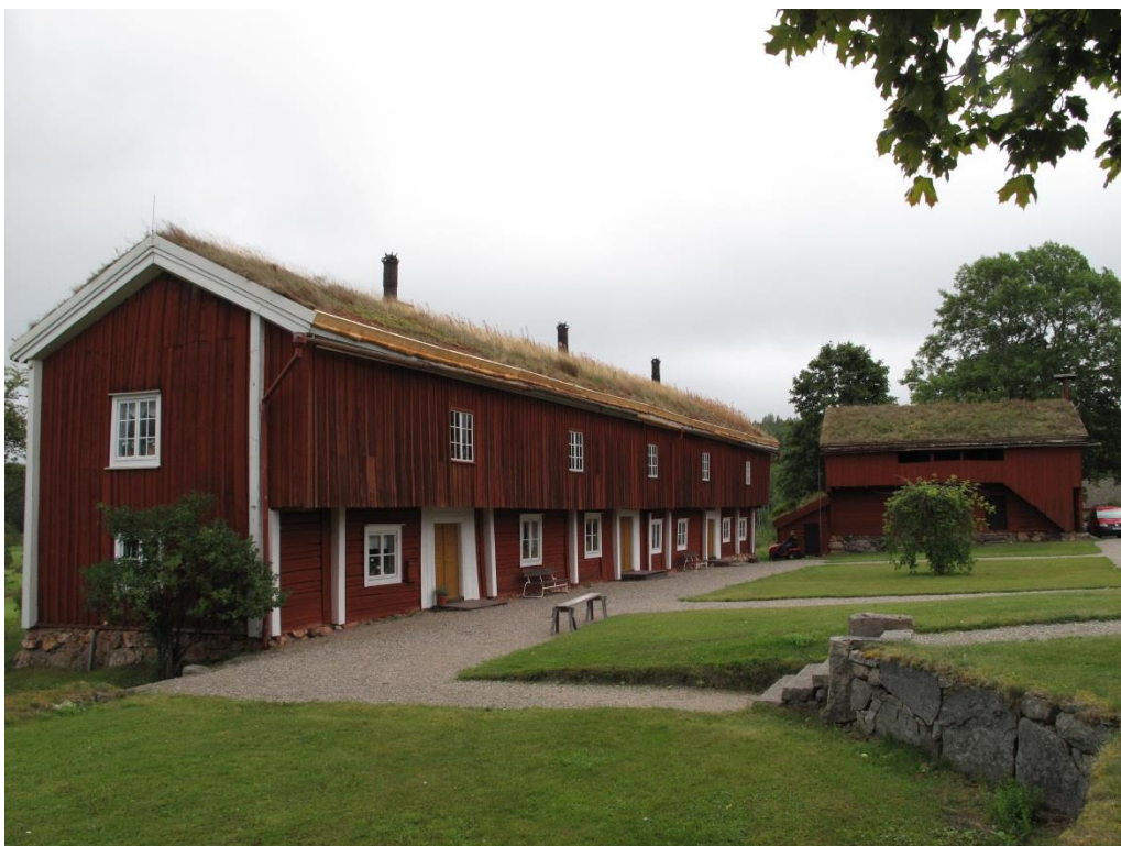
Mangårdsbyggnadens takfot efter åtgärder.
